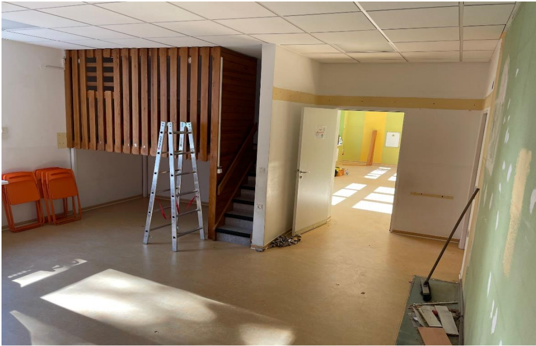
(Foto: Anfang Sept. 2023/ Vorbereitung für den Abriss des ehemaligen Theaterraumes)
