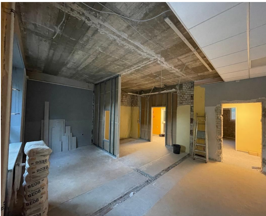
(Foto: Okt.2023/ Stellen von neuen Trennwänden mit Sichtfenster und Erweiterung der Deckenplatten)
