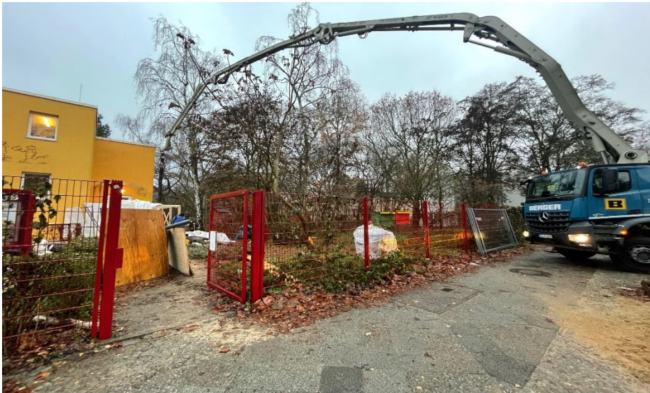
(Foto: Anfang Dez.2023/ Betonanlieferung für das Fundament des neuen Eingangsbereiches)
